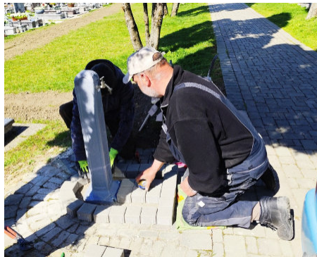
Vybudovanie vodovodu na cintoríne
