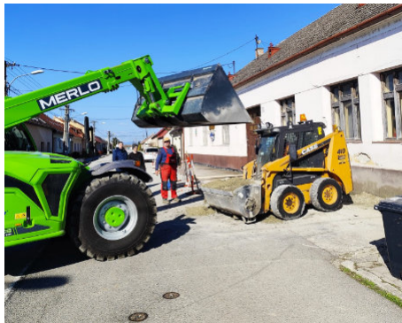
Rekonštrukcia chodníka pri pamätnej tabule SNP
