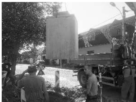
● Osádzanie vodomernej šachty pri Požiarnej zbrojnici.
