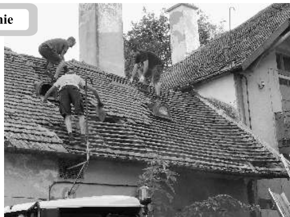
● Odstránenie strešnej krytiny na stavbe budovy hasičskej techniky.
