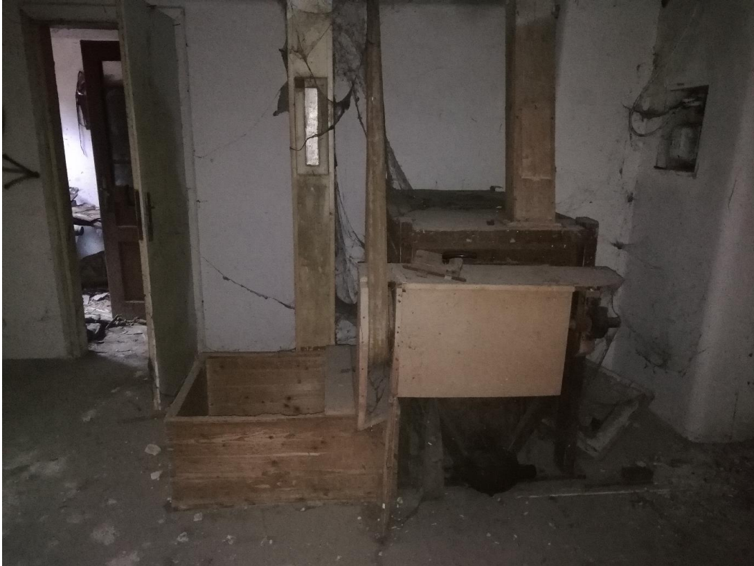
45. Východná časť mlyna – 2. NP poschodie (obydlie mlynára) korčekový výťah so zásobníkom múky (pod ním na prízemí vysypné potrubie v pekárni)
