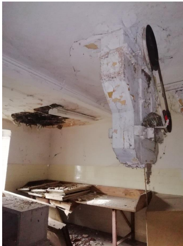
16. Interiér bytu mlynára (pekárne), 1. NP (11/2023)
