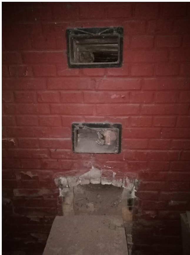
44. 1. NP východná časť mlyna (bývalé obydlie mlynára – pekára), chlebová pec z boku - prístupná zo zádveria
