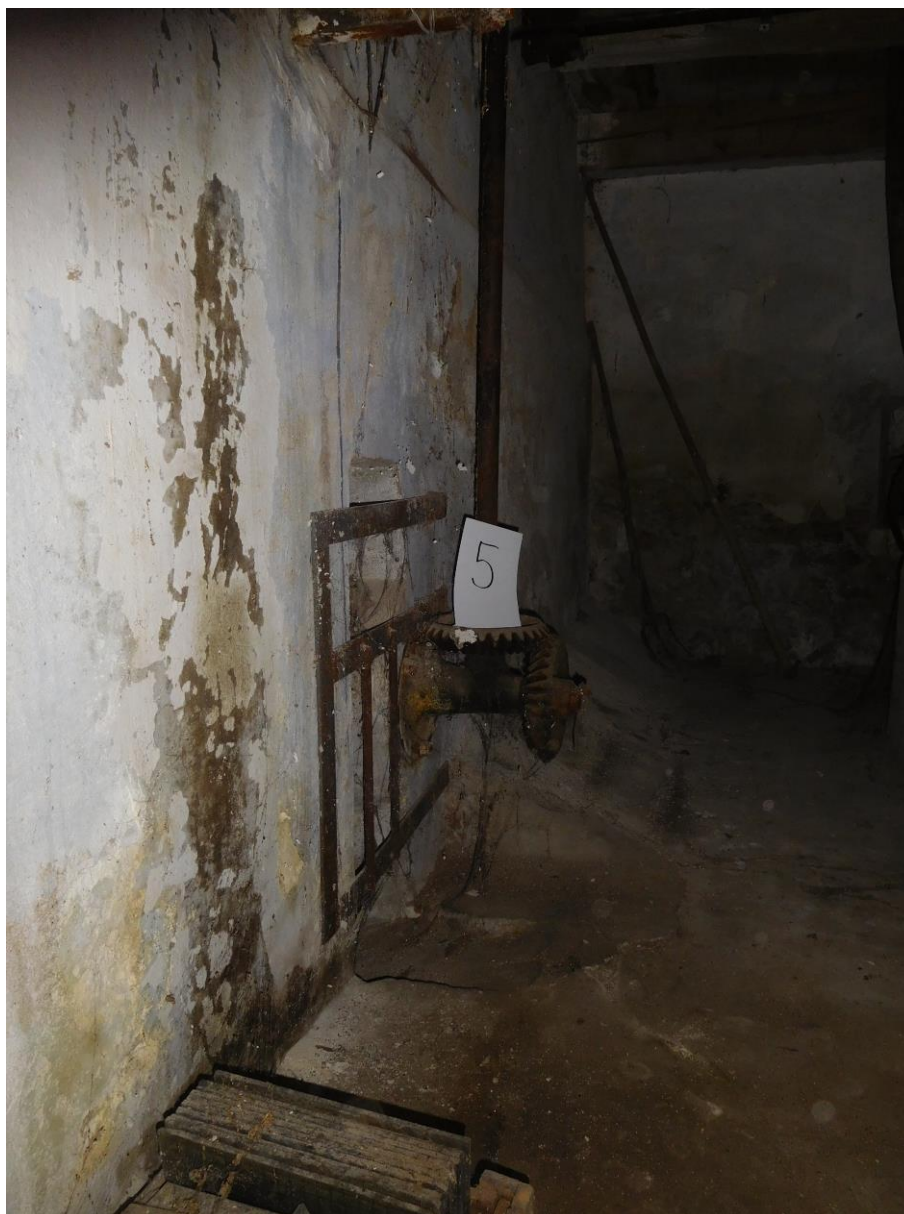
8. 1. NP – západná stena- hriadel' na ovládanie turbíny (č. 5)
