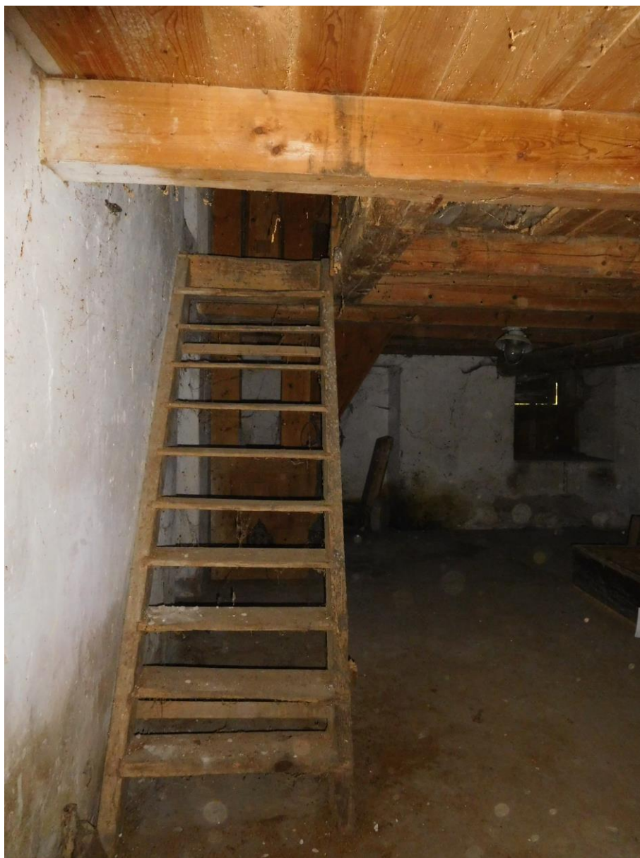
14. 1. NP - schodisko na podkrovie pri východnej stene mlynice
