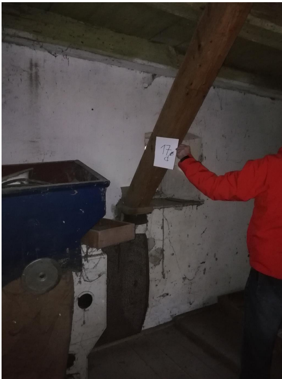
29. 2. NP - výpadové drevené potrubie s plechovým hrdlom (č. 17c)
