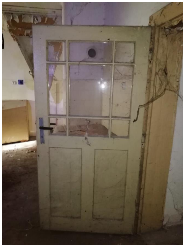
18. Interiér bytu mlynára (pekárne): 1. NP - dverná výplň vstupu do pekárne z predsiene
