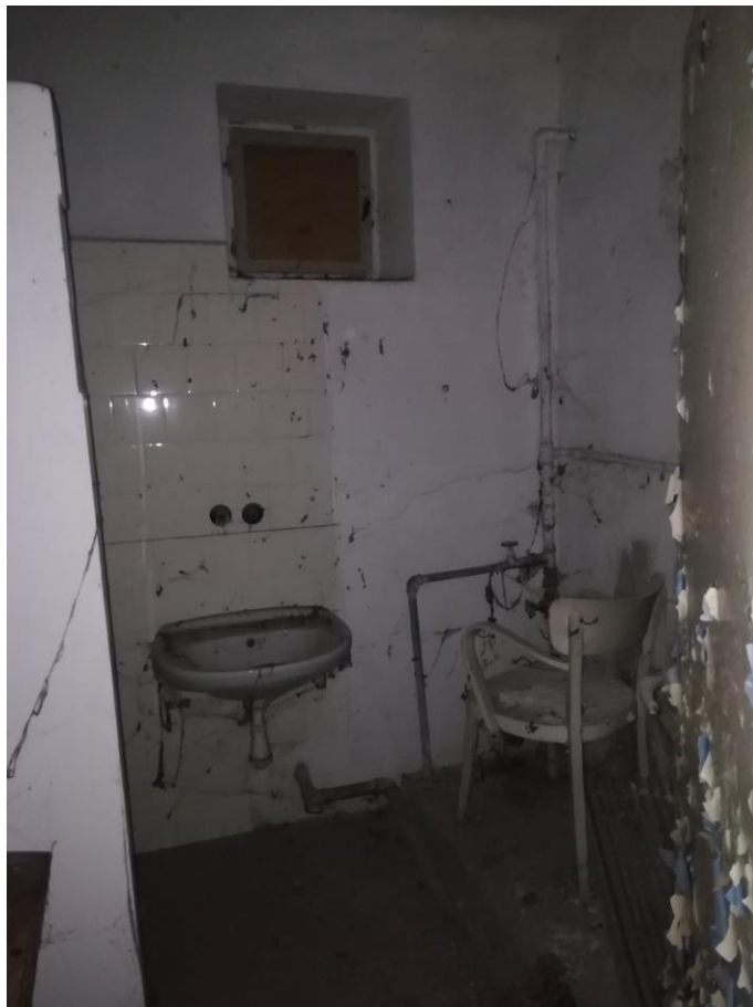
19. Interiér bytu mlynára (pekárne): 1. NP– priestor v severovýchodnej časti (soc. zariadenie)
