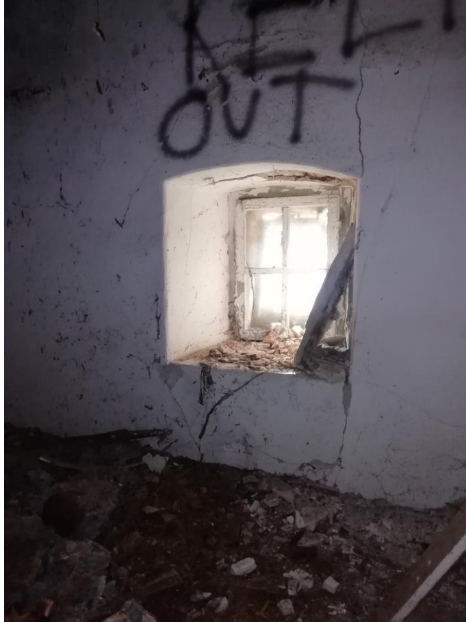
13. Byt mlynára (pekáreň): okno na 2. NP pekárne – južná stena
