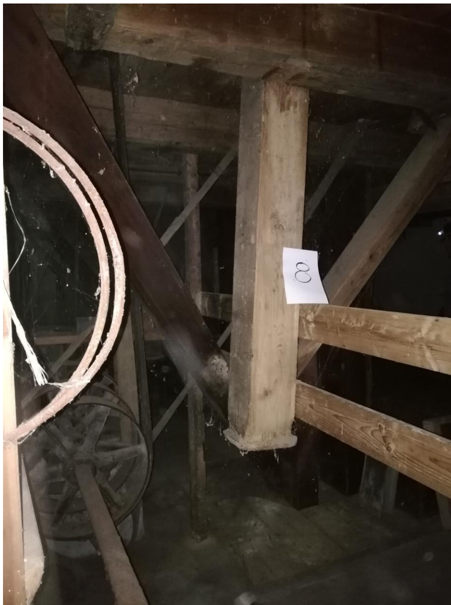
13. 1. NP – výpadové (výsypané) potrubie- celkom tri kusy (č. 8)
