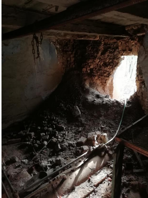
15. Interiér bytu mlynára (pekáreň): 2. NP, juhovýchodné nárožie
