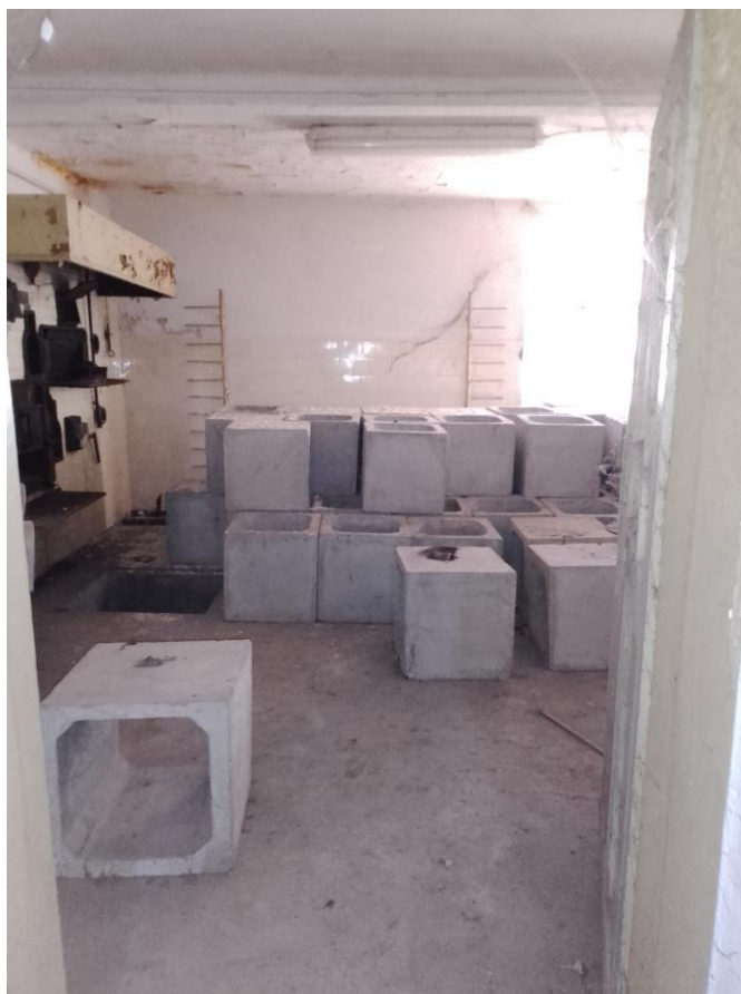
17. Interiér bytu mlynára (pekárne), 1. NP (02/2023)
