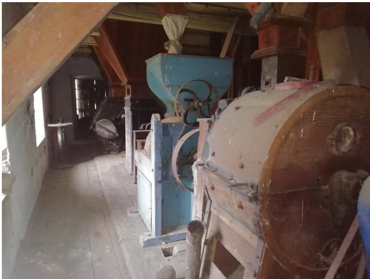
23. 2. NP – celkový pohľad na zariadenie, vľavo západná stena, vzadu valcové stolice
