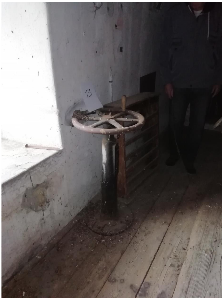
21. 2. NP – západná stena- ovládanie turbíny (stavidla?; č. 13)
