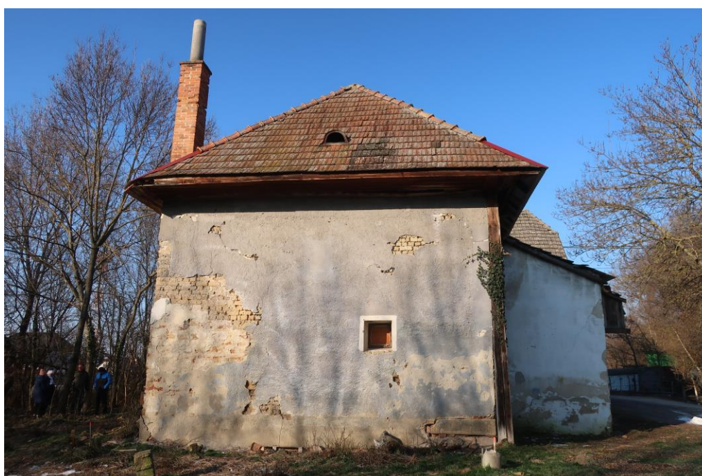
Pobedim, NKP Mlyn vodný, východná fasáda (02/2023)
