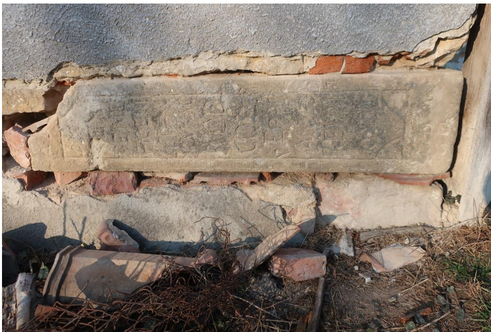
Pobedim, NKP Mlyn vodný, sekundárne zamurovaný kameň v SV nároží bytu mlynára
