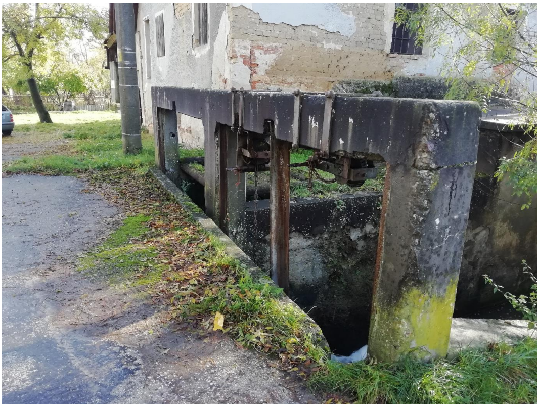
46. Stavidlo na potoku, za ním turbína a strojovňa- pristavaná k západnej fasáde mlyna
